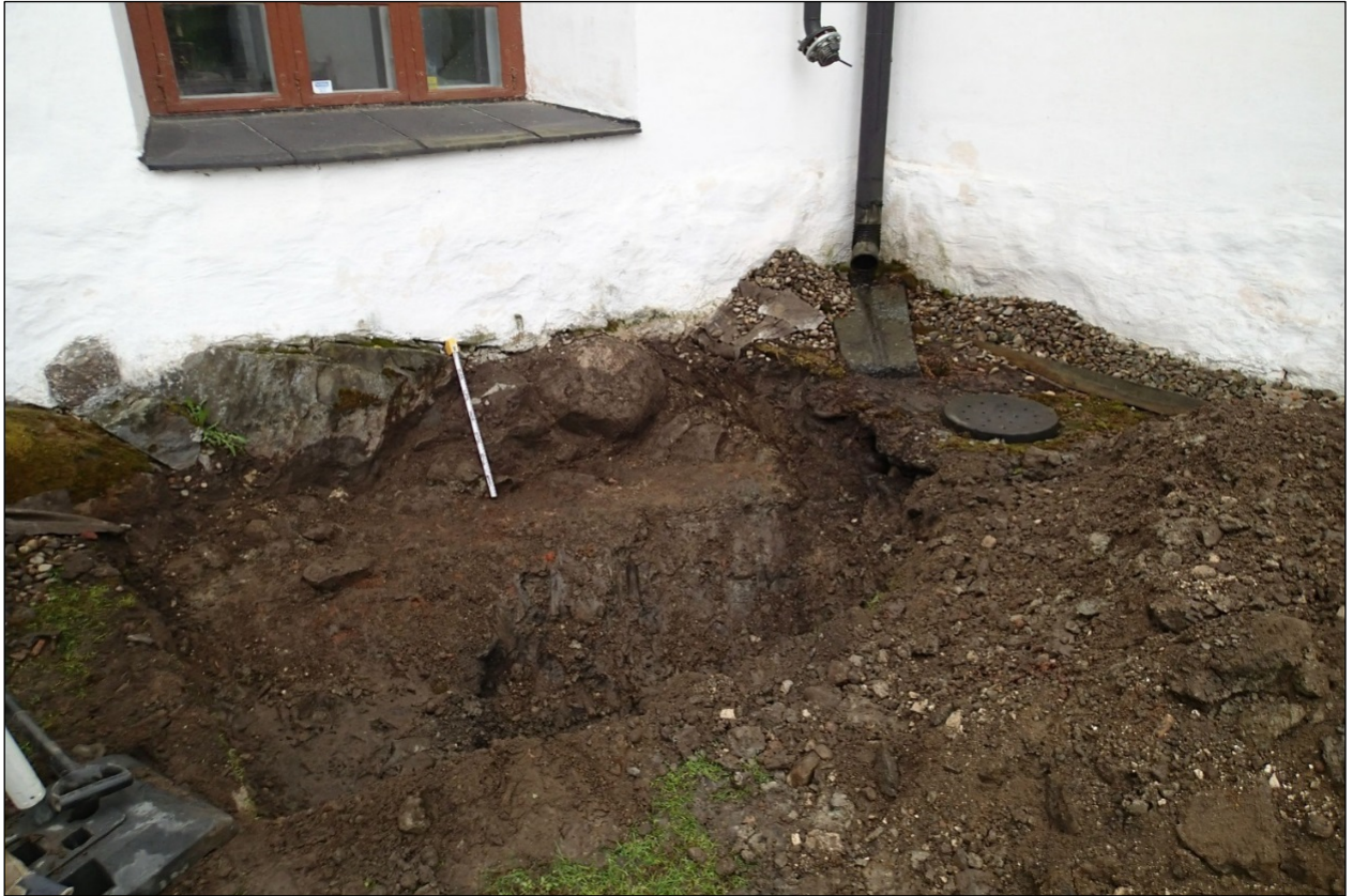
KUVA. Koekuopan 3 sijainti. Ikkunan alla pystyssä oleva mitta osoittaa tekstissä mainitun tiilimurska-alueen länsirajaa. Koillisesta.
