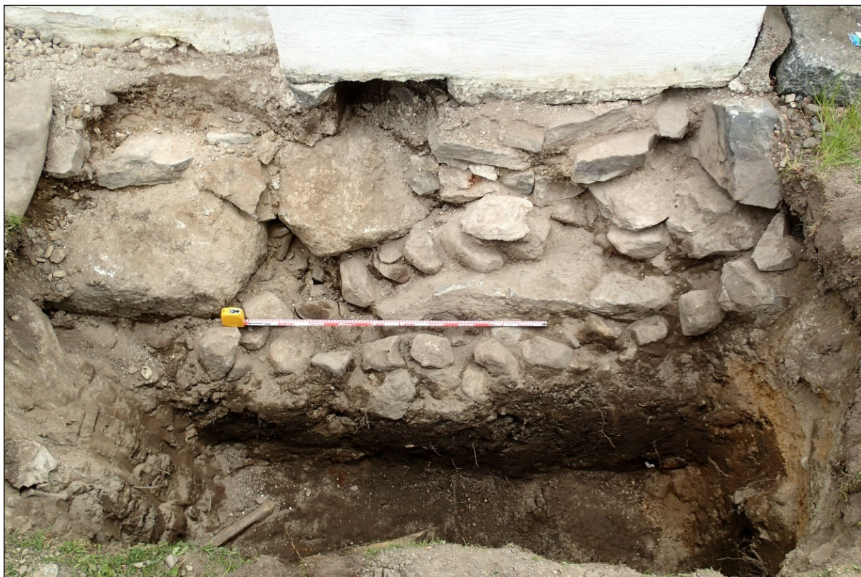
KUVA. Kirkon 1800-luvun eteläseinän perustusta koekuopan 1 pohjoisleikkauksessa. Mittanauhan pituus 1 m. Etelästä.
